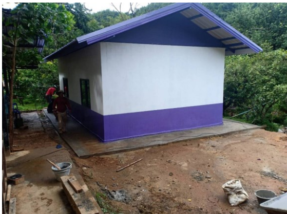
อาคารโรงเก็บเครื่องกรองน้ำ
